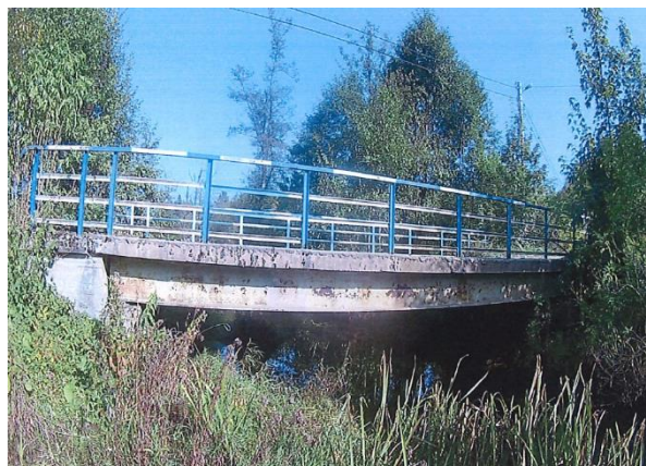
Rysunek 9. Obiekt mostowy (JNI) 35011719 Źródło: Protokół okresowej kontroli rocznej z dnia 25.09.2020
