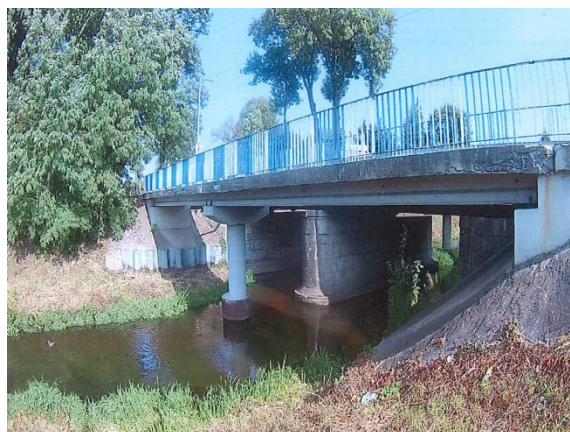
Rysunek 16. Obiekt mostowy (JNI) 08390007 Źródło: Protokół okresowej kontroli rocznej z dnia 26.09.2020
