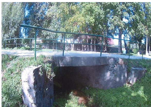
Rysunek 11. Obiekt mostowy w miejscowości Kurozwęki (w ciągu drogi 1707/1) Źródło: Protokół okresowej kontroli rocznej z dnia 25.09.2020
