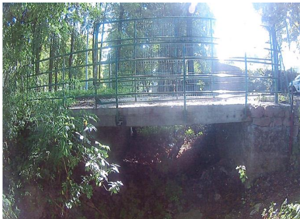
Rysunek 12. Obiekt mostowy w miejscowości Kurozwęki (w ciągu drogi 1705)
