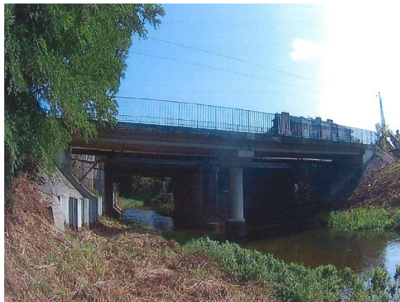
Rysunek 15. Obiekt mostowy (JNI) 08390006 Źródło: Protokół okresowej kontroli rocznej z dnia 26.09.2020
