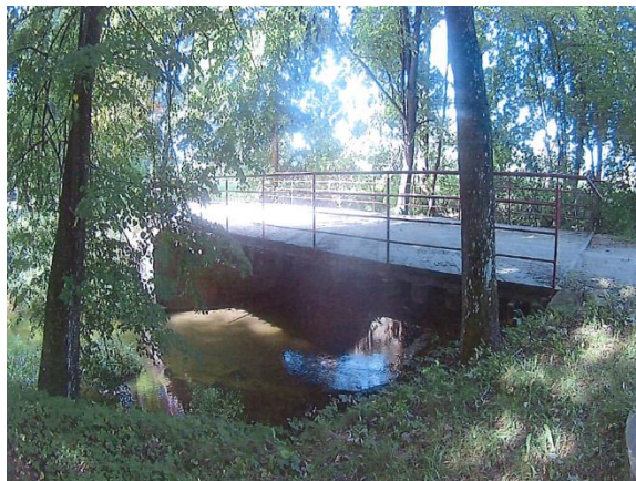
Rysunek 13. Obiekt mostowy w miejscowości Kurozwęki (w ciągu drogi 1705)
