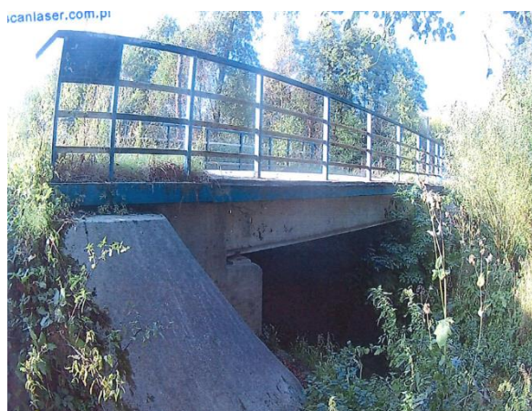
Rysunek 10. Obiekt mostowy w miejscowości Łaziska (dz. Nr. 479/2) Źródło: Protokół okresowej kontroli rocznej z dnia 25.09.2020
