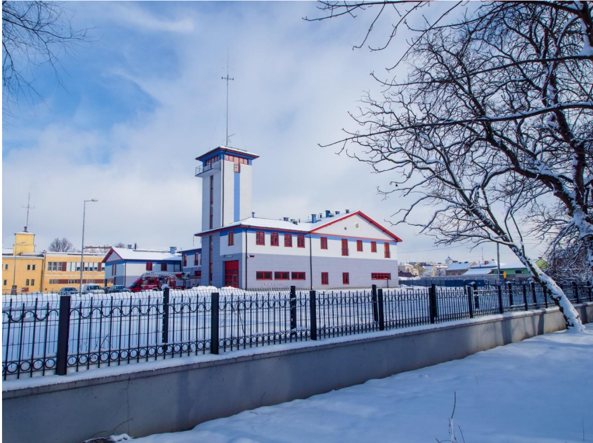
Zdjęcie: Budynek KP PSP w Staszowie.
